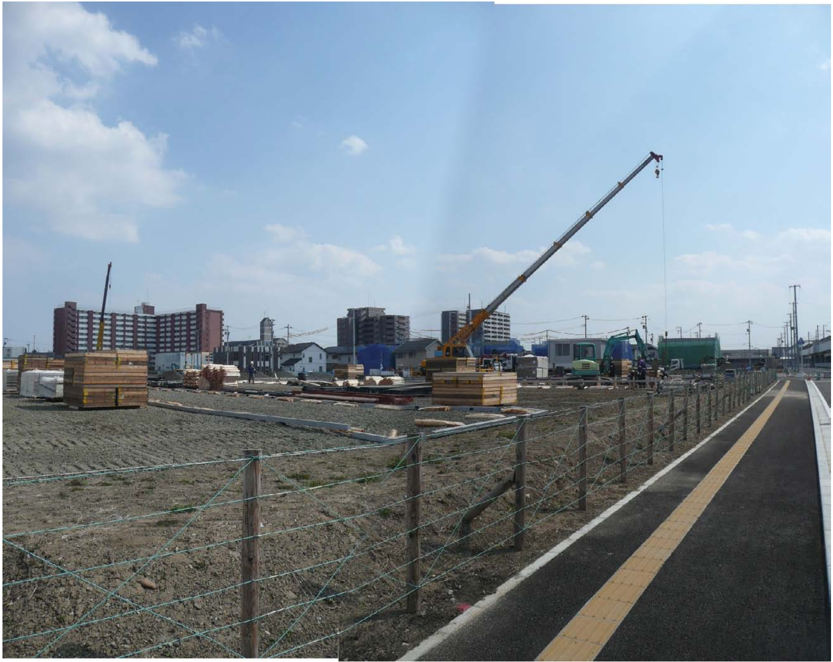
2011.03.29 仮設住宅3/29着工
